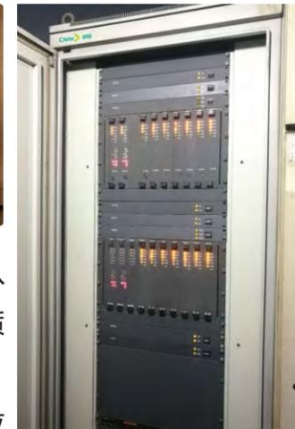
11月29日上午，济南绿控销售经理张帆接到淄博火炬能源客户反应DCS系统存在异常后，立即赶往现场，与现场人员沟通后发现问题为模块离线。经在现拔下模板检查，发现由于系统长期运行，现场环境恶劣，导致模板内部堆积了大量灰尘。在利用专用清尘工具进行简单灰尘清理后重新装上模板，系统故障得到排除！
