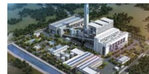
浙江泰亿能源热电联产项目
