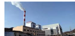
陕西延安热电厂2*75t/h循环流化床锅炉+15MW机组控制系统
