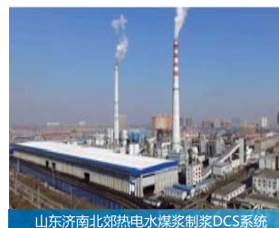
山东济南北郊热电水煤浆制浆DCS系统
