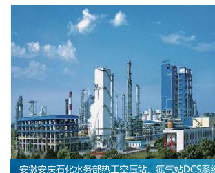
安徽安庆石化水务部热空气空压站、氮气站DCS系统
