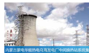
内蒙古蒙电华能热电乌海发电厂中间换热站系统集成
