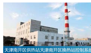
天津南开区供热站天津南开区换热站控制系统
