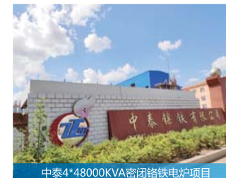
中泰4*4800KVA密闭铬铁电炉项目
