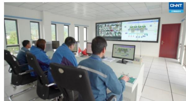
本项目控制核心采用正泰中自自主研发的正泰泰美水处理控制系统。此套继承了DCS全冗余、高可靠性，又兼具PLC安装配置灵活、外部接口丰富等特点的分布式控制系统，曾荣获“省级优秀工业产品”和“中国好仪表”等称号。
